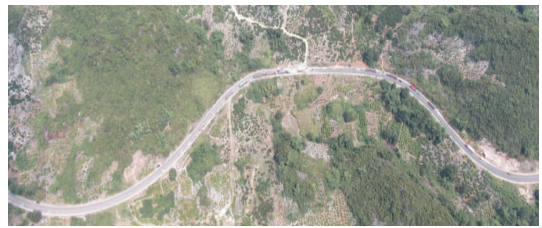
图 1 事故多发路段之实景
