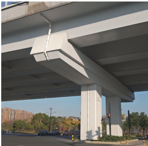
图 3 嘉兴市快速路环线工程排水管布置
