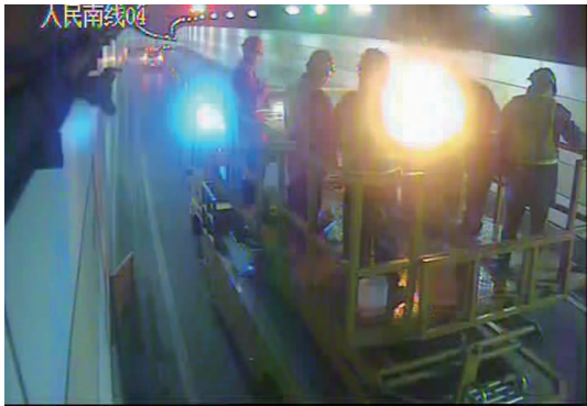
图8 隧道移动点火灾试验
