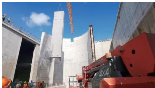
图3 叠合墙现场吊装
