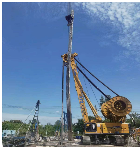
图 7 接头箱打捞完成
