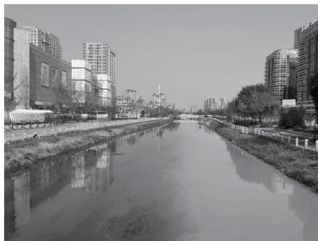
图5 涝淄河现状河道
