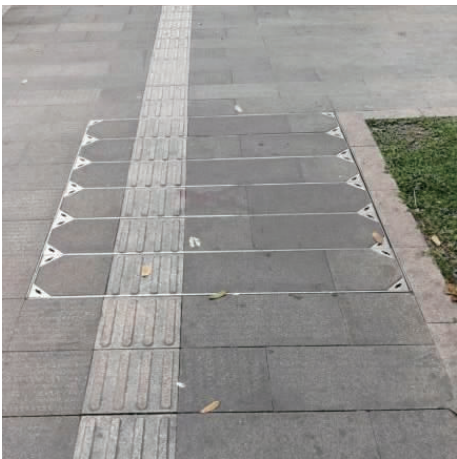
图 1 沿人行道布置的电缆沟
