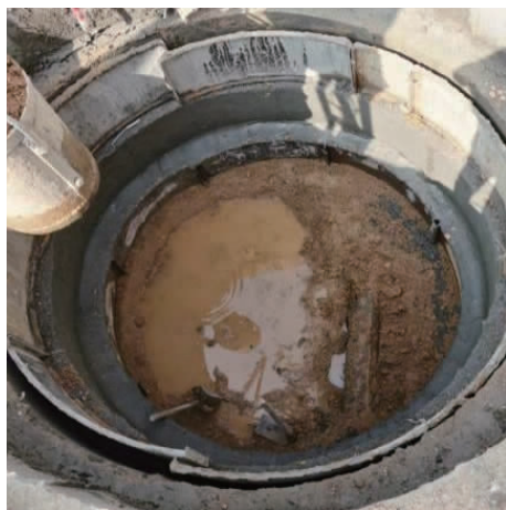
图4 桩位下发现给水管
