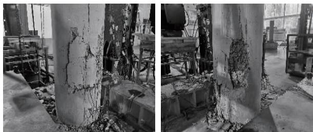
(a)正面 (b)背面 图7 2#试件加载结束后裂缝分布
