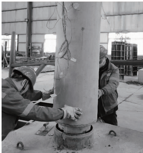
图4 立柱安装
