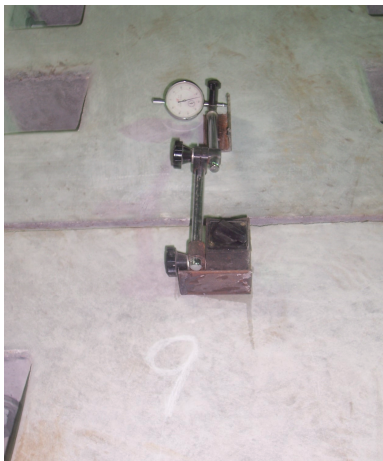
图7 安装好后的实景
