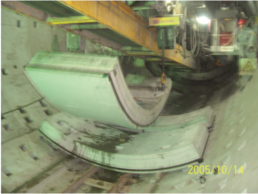
图2 施工现场管片吊装情况之实景
