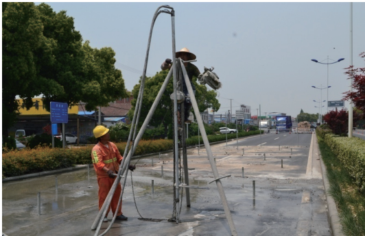
图 1 DGR 工艺现场注浆之实景
