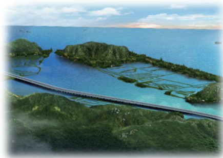
图 1 项目场址地貌
