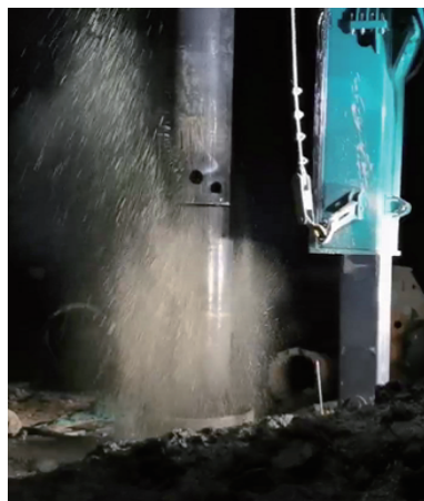
图 8 潜孔锤成孔施工现场
