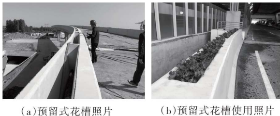
图 11 带花槽防撞护栏实景
