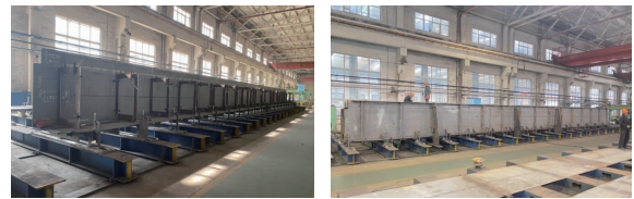
图7 轨道梁整体组焊工装使用
