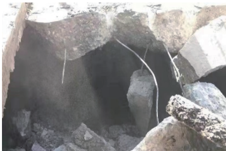
图 1 道路空洞案例图示
