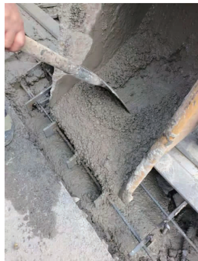
图7 施工现场浇筑
