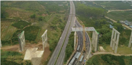
图 8 渡线施工完毕后吊装边跨钢梁
