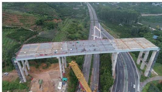
图6 吊装完毕的钢箱梁
