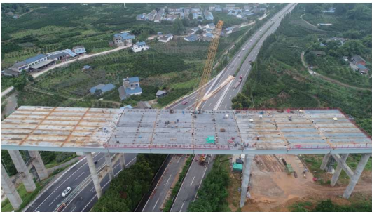
图 9 车辆于渡线处通行并吊装跨中钢梁
