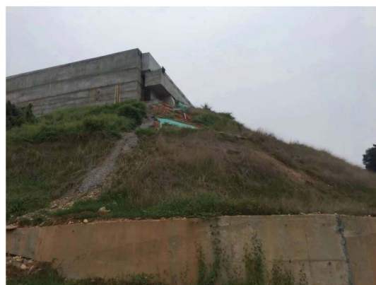
图 16 施工完的 0# 桥台
