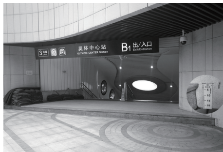
图 3 济南地铁奥体中心站 B1 出入口水位标记线等详细内容。
