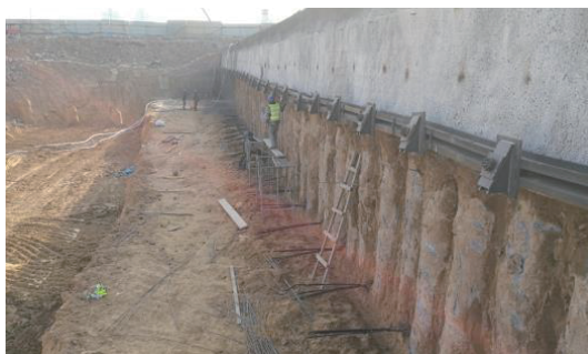
图 5 箱体段悬臂式排桩+预应力锚索支护
