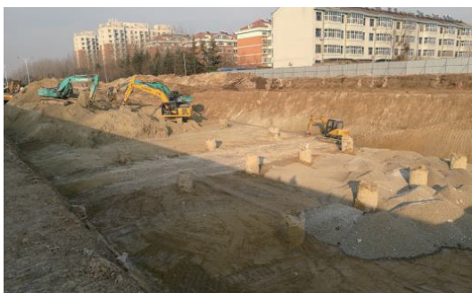
图 6 U 型槽段放坡开挖
