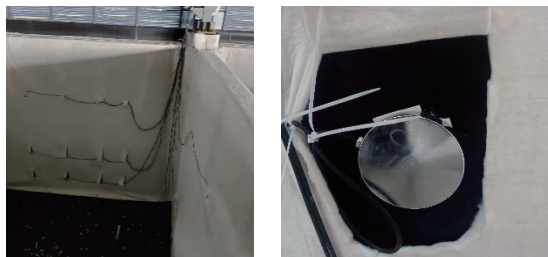
图 3 现场实验压力传感器安装情况
