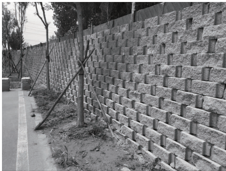
图 16 石砌和空心砌块边坡配合使用示意图
