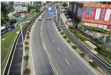
图 13 横芙路(朝阳路~常芙路段)实施后实景
