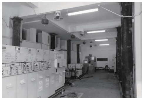
图5 应急加固室内地梁与钢立柱图示
