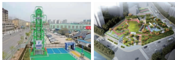
图14 新亨东路、东新南路公共停车场
