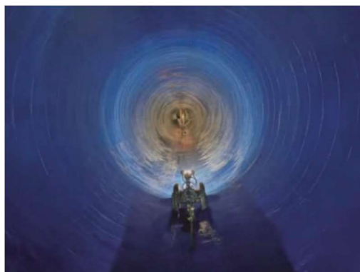
图 7 内衬管外观验收检测
