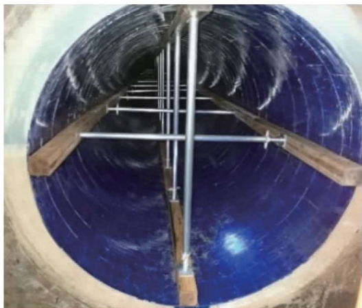
图 6 注浆前支撑情况
