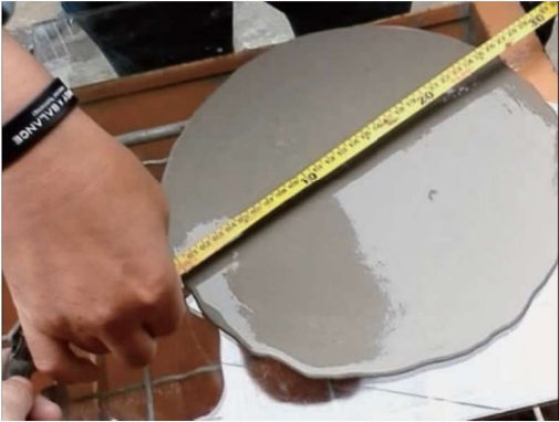
图 4 现场检测填充砂浆流动度
