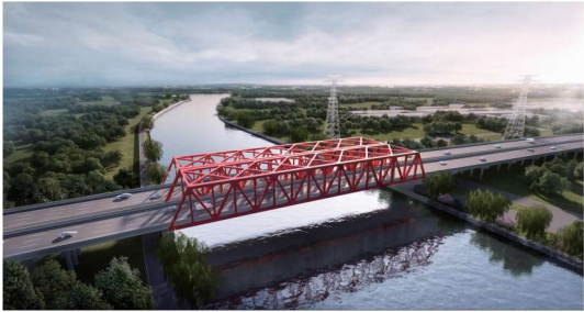
图 2 下承式钢桁架结构
