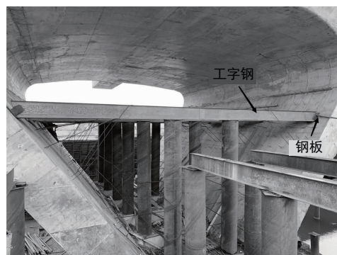
图4 内部支撑现场图
