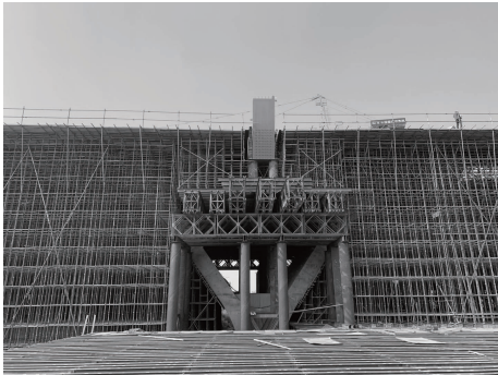
图5 V型墩现场支撑图
