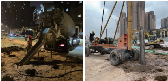
图 4 桥台台背挡土墙桩基础施工现场
