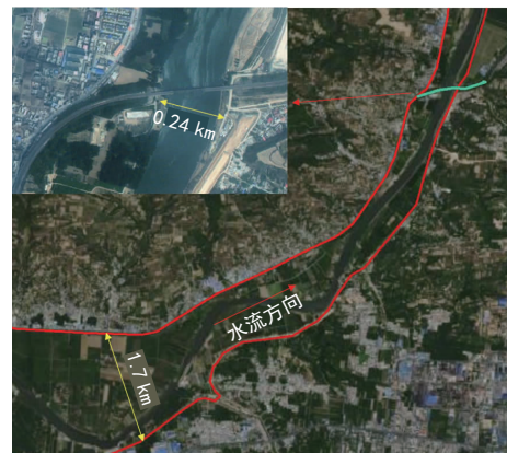
图4 陇海铁路伊洛河桥区域河段
