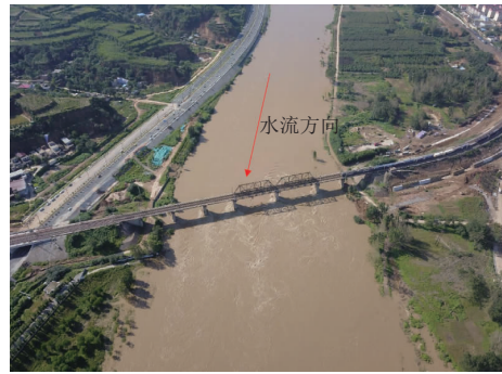
图3 陇海铁路伊洛河桥航拍
