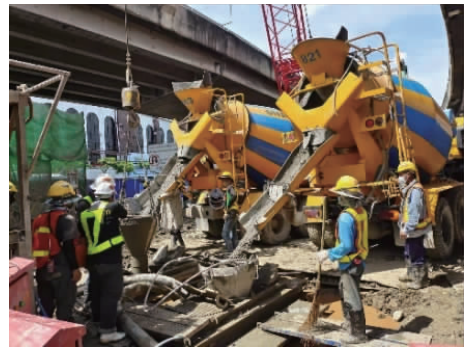
图7 混凝土浇筑
