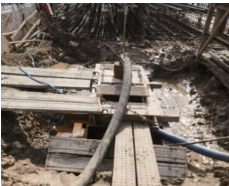
图5 泵吸反循环清孔
