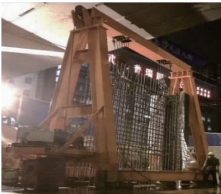
图4 龙门吊吊装
