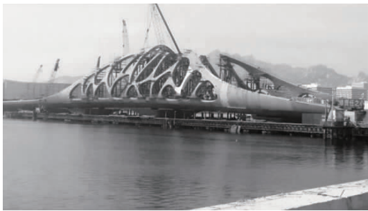
图12 珊瑚贝桥钢结构桥面拼装施工
