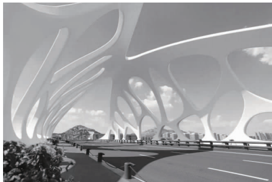
图8 珊瑚贝桥附属设施建成实景
