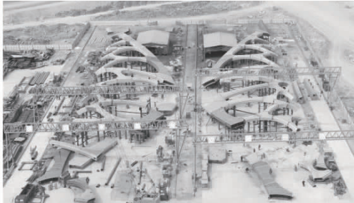
图11 珊瑚贝桥钢结构拱现场预拼装施工
