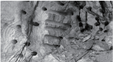
图8 现场钻孔与劈裂
