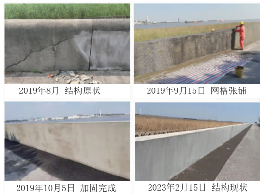
图8 加固结构影像
