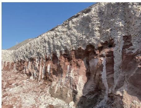
图 14 洞顶加固效果(仰坡开挖后)
