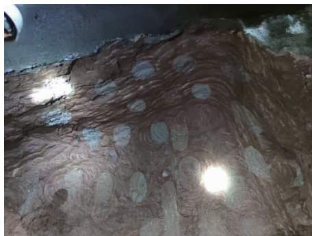
图 15 洞顶加固效果(洞内掌子面)
