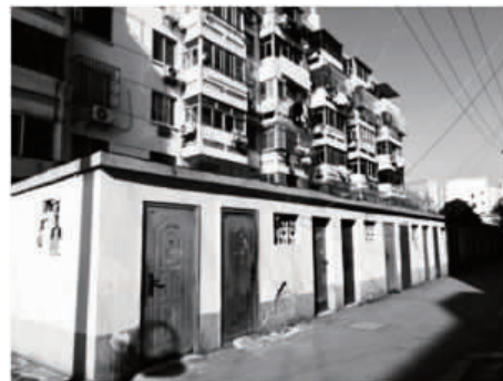
图8 一楼庭院现场照片
