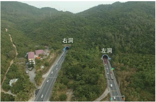
图 2 现状大茅隧道洞口(西端)航拍图
