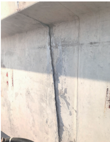
图 7 拼接面环氧砂浆均匀挤出
