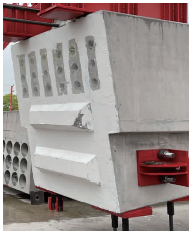
图3 剪力键布置示意图
