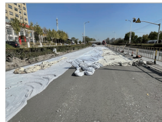
图7 再生水稳施工
