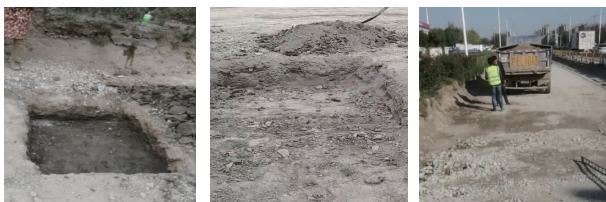
图6 土路基局部加固
