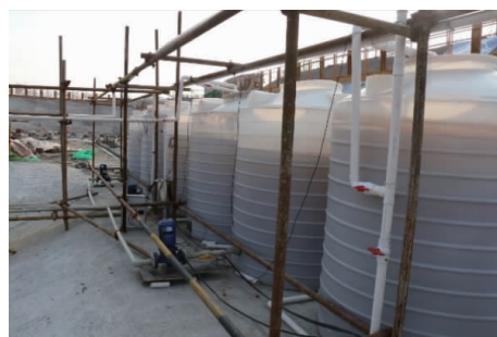
图 10 进、出水口冷却水混合
