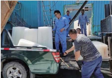
图 11 加冰水拌合
