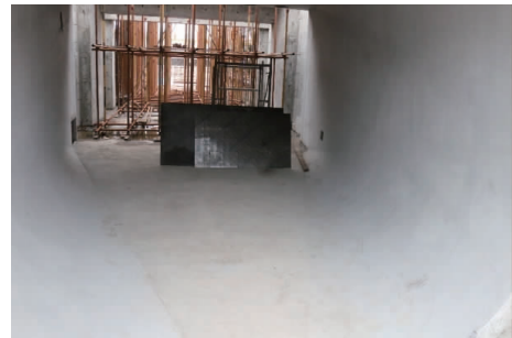
图 16 泵站流道实体混凝土质量
