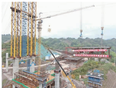
图8 缆索吊装系统试吊现场施工图
