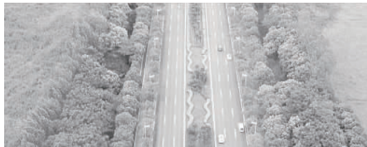
图 4 水华路以东现状断面照片
