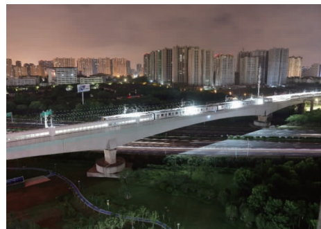
图2 轨道交通桥梁实景图
