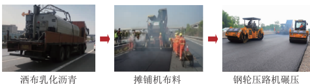
图 3 超薄磨耗层同步摊铺施工
