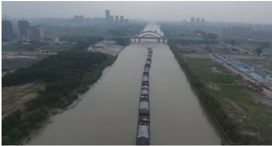
图 2 拟建桥位航拍图
