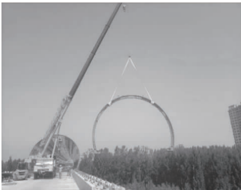
图 7 桥面拱架吊装
