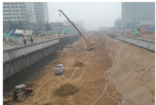
图7 基坑支护施工实景
