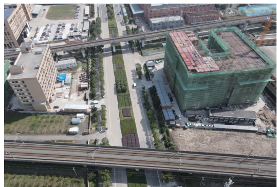
图1 转体桥位置现场照片
