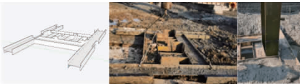
图4 自限制位器示意图及施工现场图
