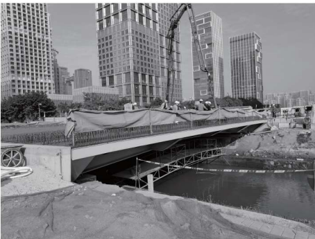
图 5 桥梁与地铁站台合建建设照片
