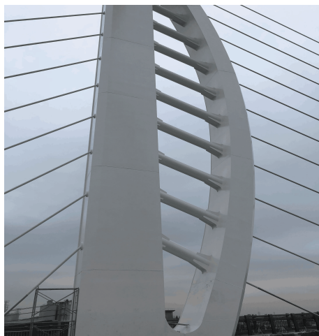
图 11 塔柱成桥之实景
